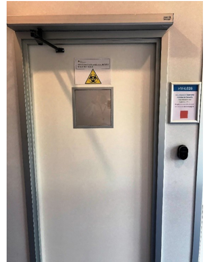
Imagen 24. Entrada a la zona de aislamiento de Animales de compañía del Hospital Clínico Veterinario UCH-CEU. Observen que el acceso está restringido mediante tarjeta digital de puerta.
